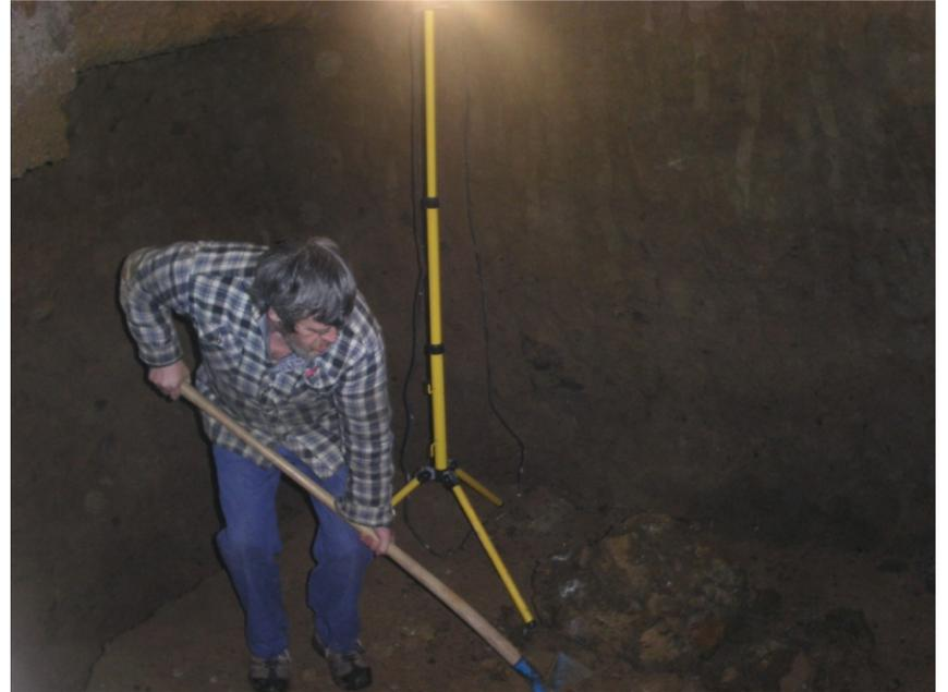
In der Sommerpause wurde der Kugelfang saniert. Eine neue Verordnung verlangte, dass die abgeschossenen Projektile nicht mehr ins Erdreich eindringen dürfen. Somit musste der Kugelfang mit einem Kugelfangsystem ausgerüstet werden.
